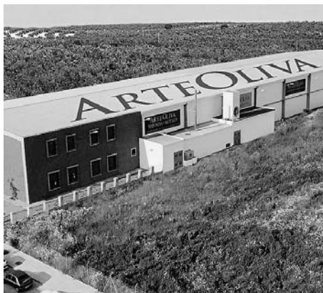
Instalaciones de Arteoliva en Palma del Río (Córdoba).
